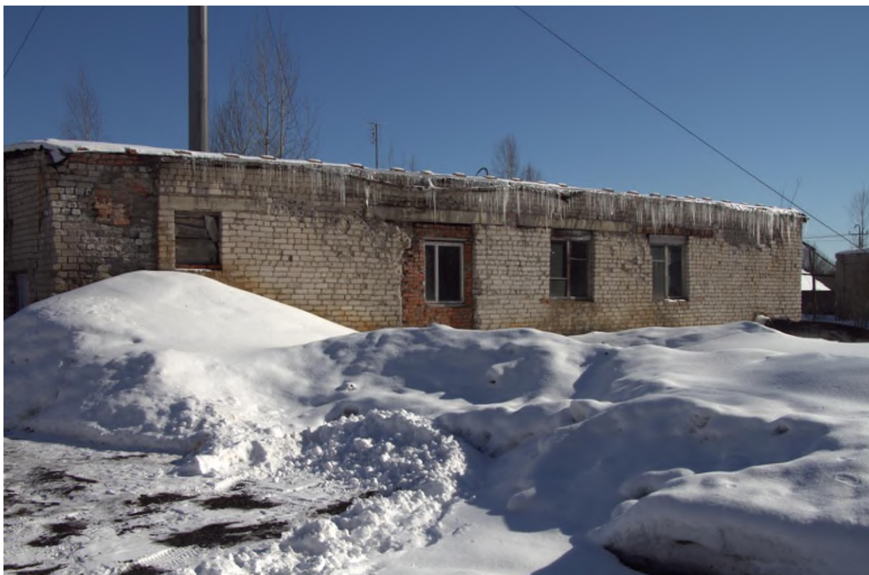
Внешний вид котельной
